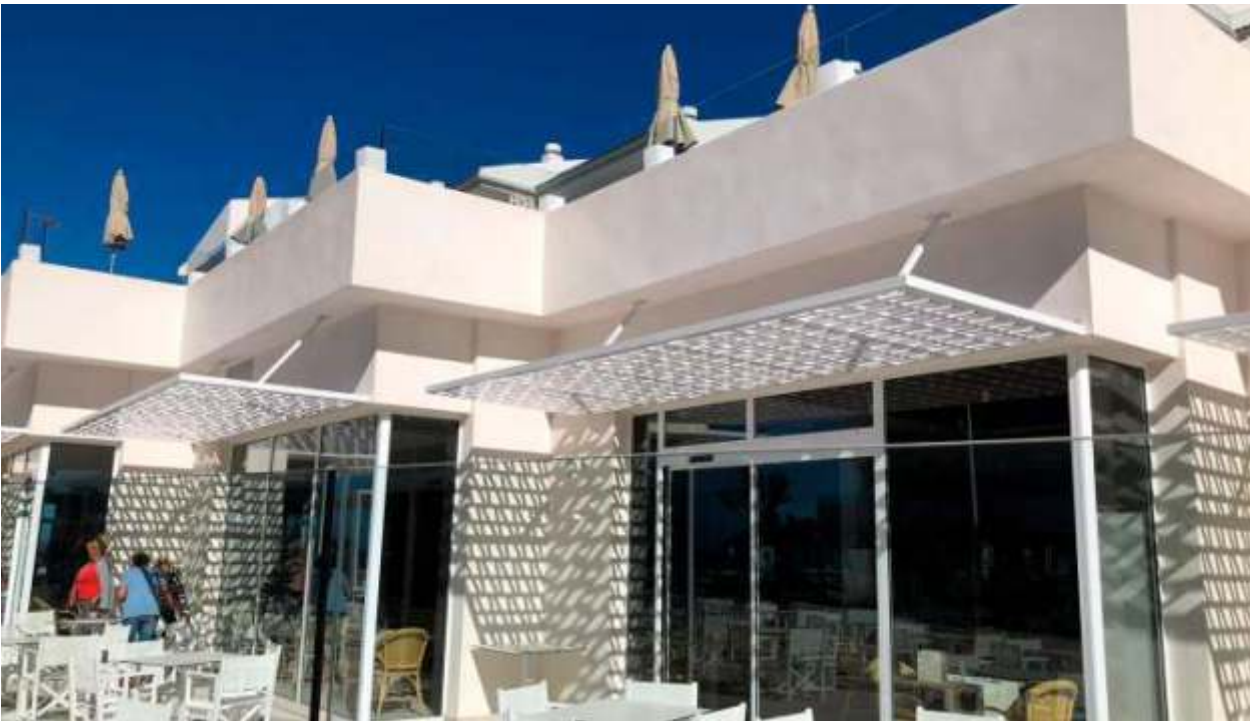
Forex de 19mm fresado y pintado de color blanco mate. Soporte de estructura de hierro galvanizado y pintado de color blanco Grupotel.
