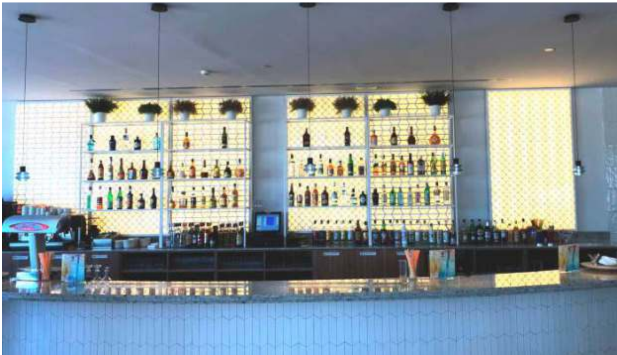
Cajón en alupanel fresado, con trasera en metacrilato blanco opal. Iluminación interior mediante leds de luz calida. Grupotel.
