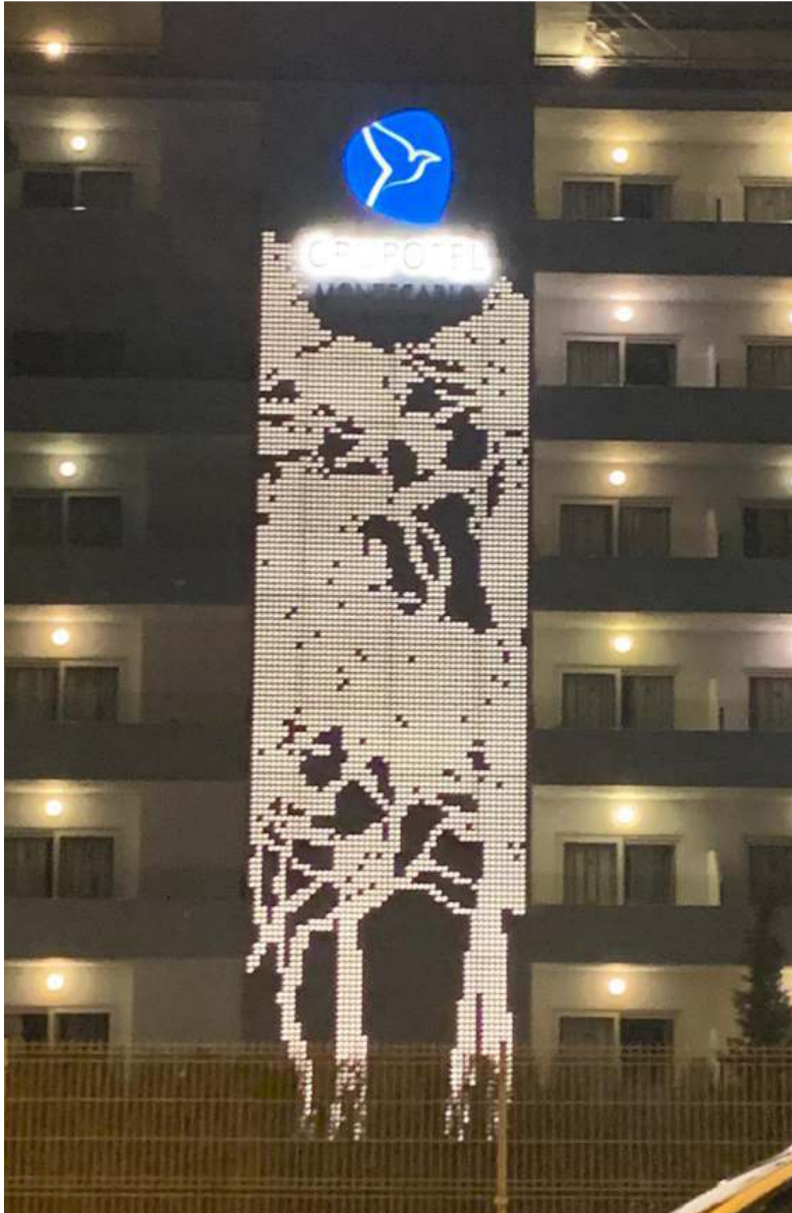
Fachada ventilada, con alupanel fresado. Estructura interior en hierro galvanizado. Iluminación mediante leds de luz calida. Letrero en corpóreo. Grupotel.
