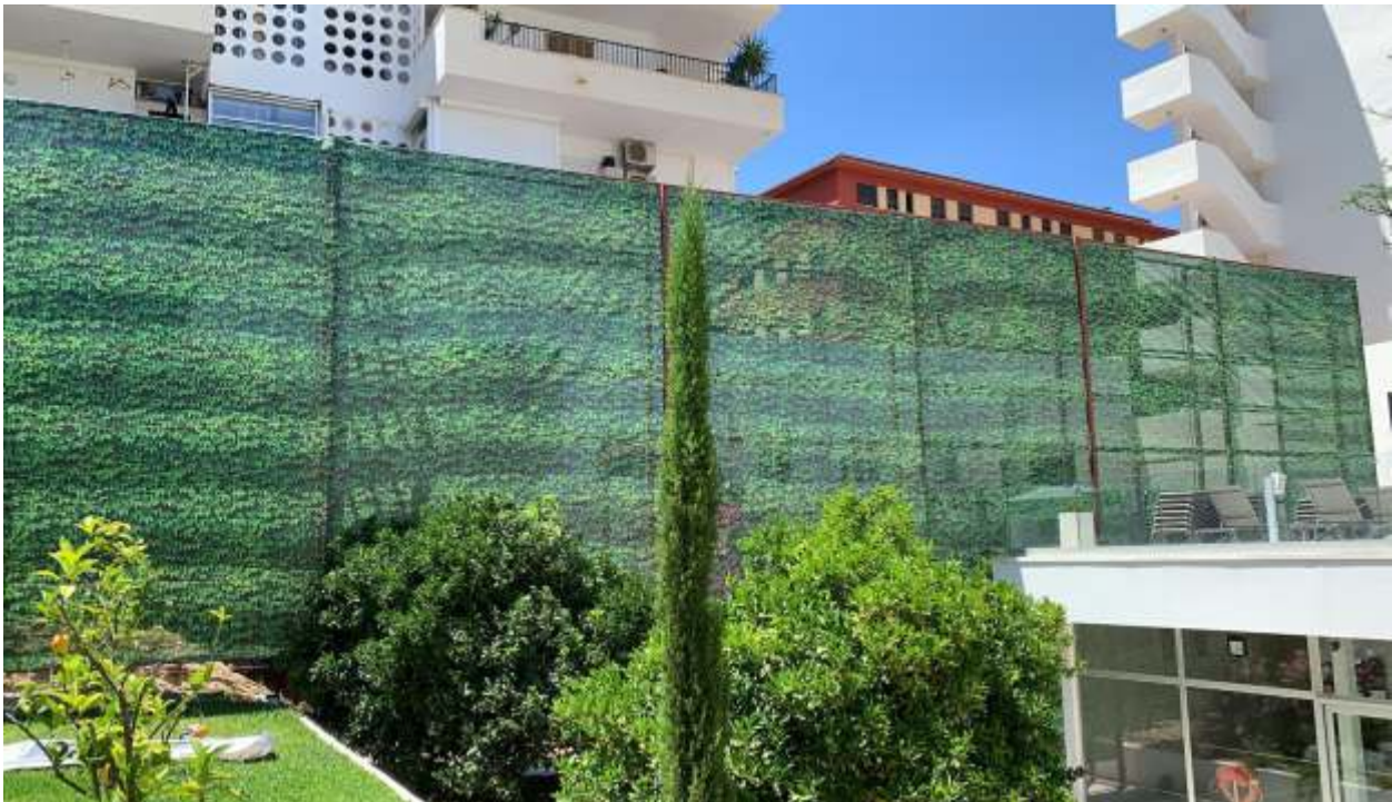
Impresión sobre lona microperforada para tapar estructura interior. Hotel INNSIDE Bosque
