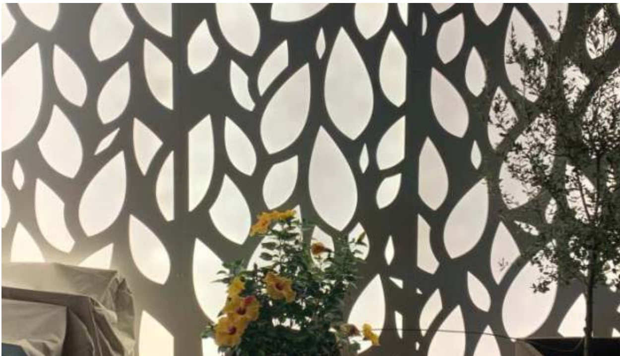
Paneles de forex de 8mm, fresados y pintados blanco mate. Com metacrilato blanco opal e iluminación con leds de luz natural. Particular
