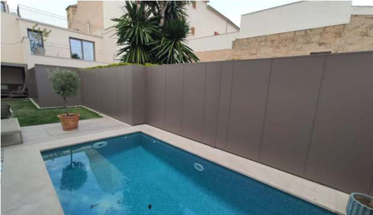
Cerramiento en alupanel con estructura de hierro. Todo pintado. Casa particular en Santa Catalina.
