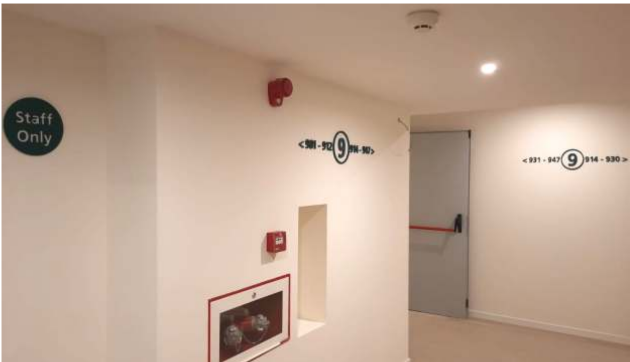
Rotulación interior para hotel. En PVC de 20mm, pintado a color. Hotel BQ Belvedere
